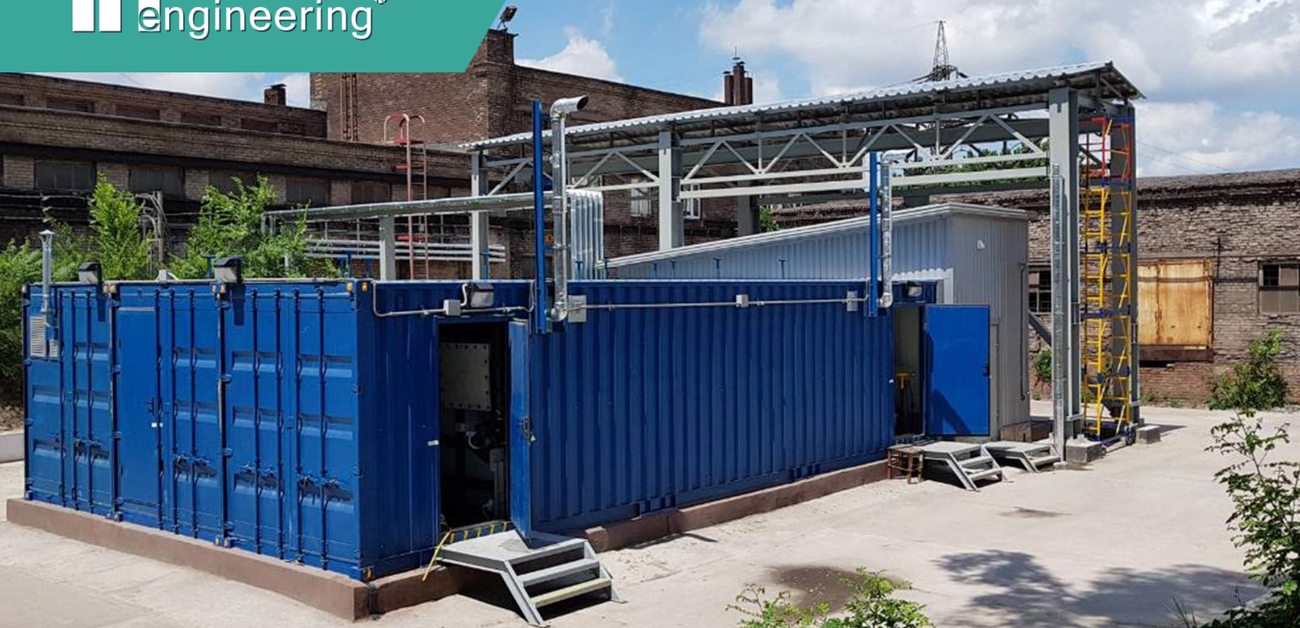
УСТАНОВКА ЭЛЕКТРОЛИТИЧЕСКОГО ХЛОРИРОВАНИЯ ПИТЬЕВОЙ ВОДЫ
