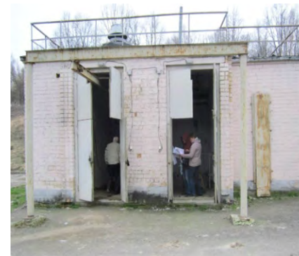
Головна каналізаційна насосна станція (вид ззовні)
