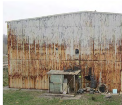
Будівля очисних споруд
