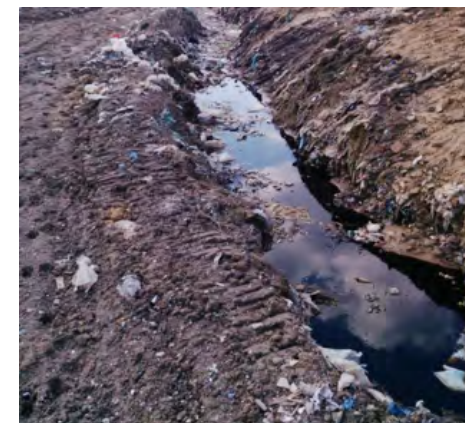
Загальний вигляд траншеї вздовж південного укосу
