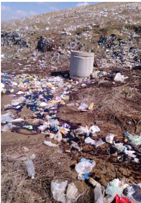
Загальний вигляд оглядового колодязя ДК4
